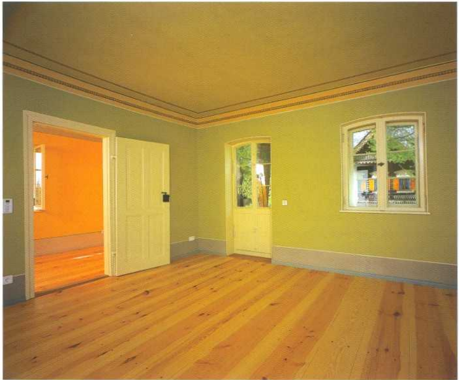
Stube im Obergeschoss mit Blick zur Straße. Hier wurde eine klassizistische Wandgestaltung (Fassung II) mit illusionistischen Eierstab-Friesen an der Oberwand und an der Decke rekonstruiert.
