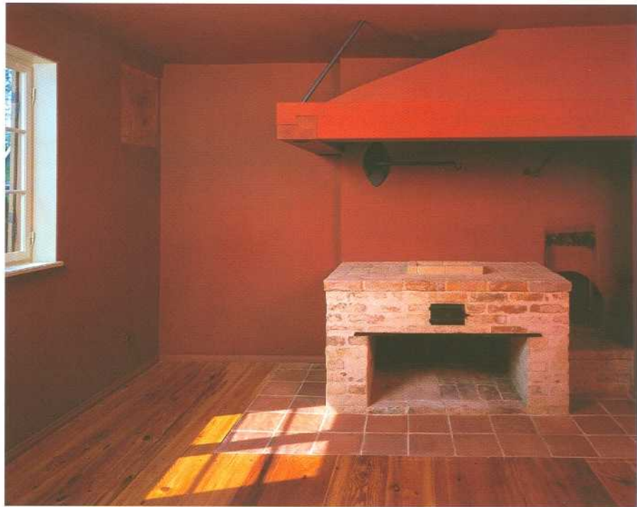
Küche im Erdgeschoss mit rekonstruiertem Rauchfang und Rekonstruktionsversuch einer Herdstelle. Links oben befindet sich ein Befundfeld mit der freigelegten ursprünglichen roten Wandfassung.
