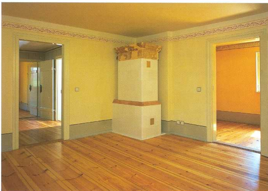
Stube im Erdgeschoss mit einer rekonstruierten Wandfassung aus der Mitte des 19. Jahrhunderts (Fassung VII). Der von der Küche aus beheizbare Ofen wurde unter Verwendung originaler Fundstücke wiederhergestellt.
