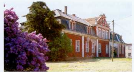
Potsdam, Ortsteil Satz Korn, Gutshaus.
