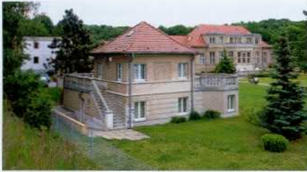
Potsdam, Ortsteil Neu Fahrland, Villa Adlon.
