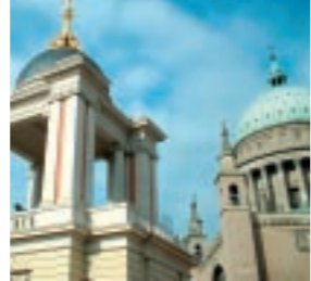
Odbudowany portal Fortuny
